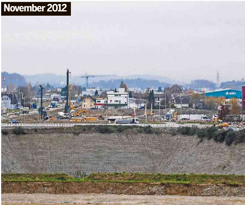
25 Meter in die Tiefe: erste Erdarbeiten auf der Coop-Baustelle.
