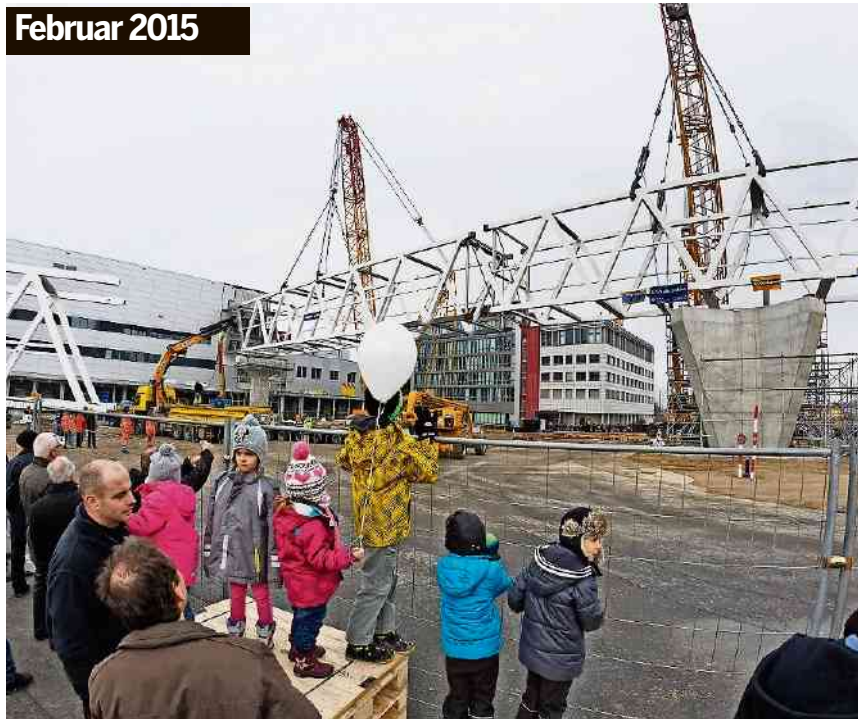
12 Meter in die Höhe: Einbau der 880 Tonnen schweren Passerelle.
