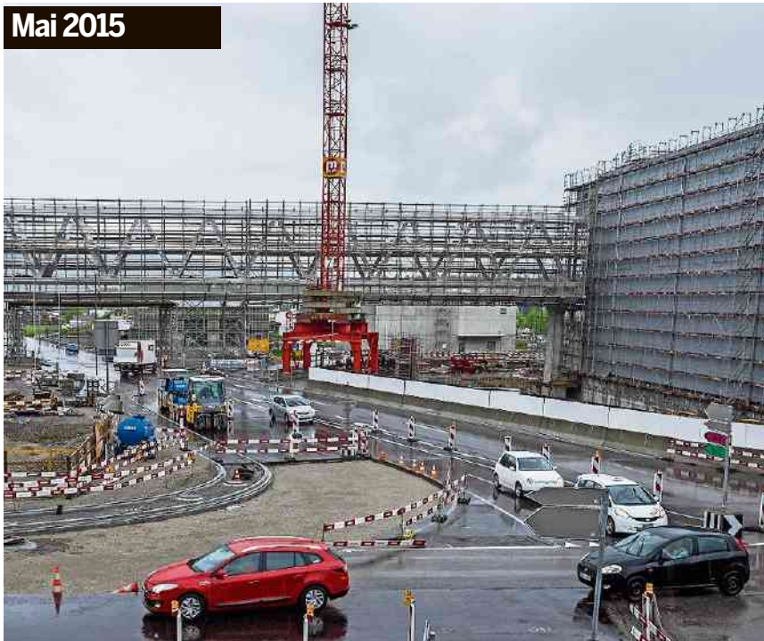
Der Rohbau steht: rechts im Bild Bäckerei und Tiefkühlager.
